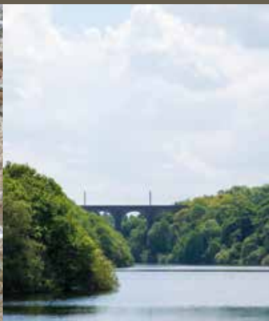
Viaduc de la vallée du Gouët
